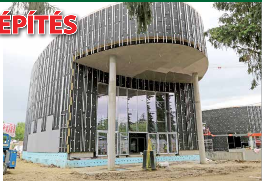
A fogadóépületet most még a fekete szigetelés borítja. Fotók: Juhász Ákos
