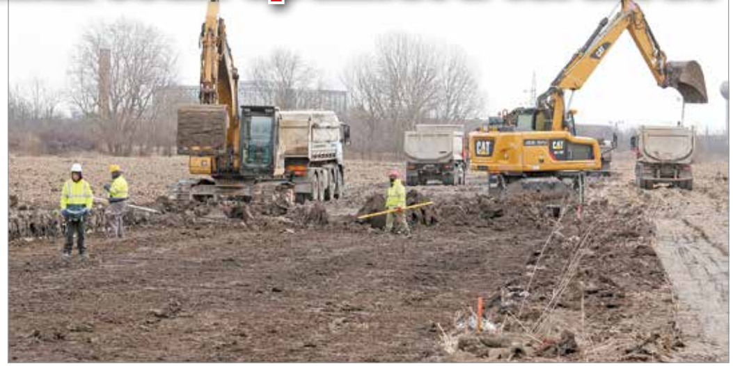
Rövidesen megkezdődhetnek a látványos útépítési munkálatok is. Fotó: Juhász Ákos
