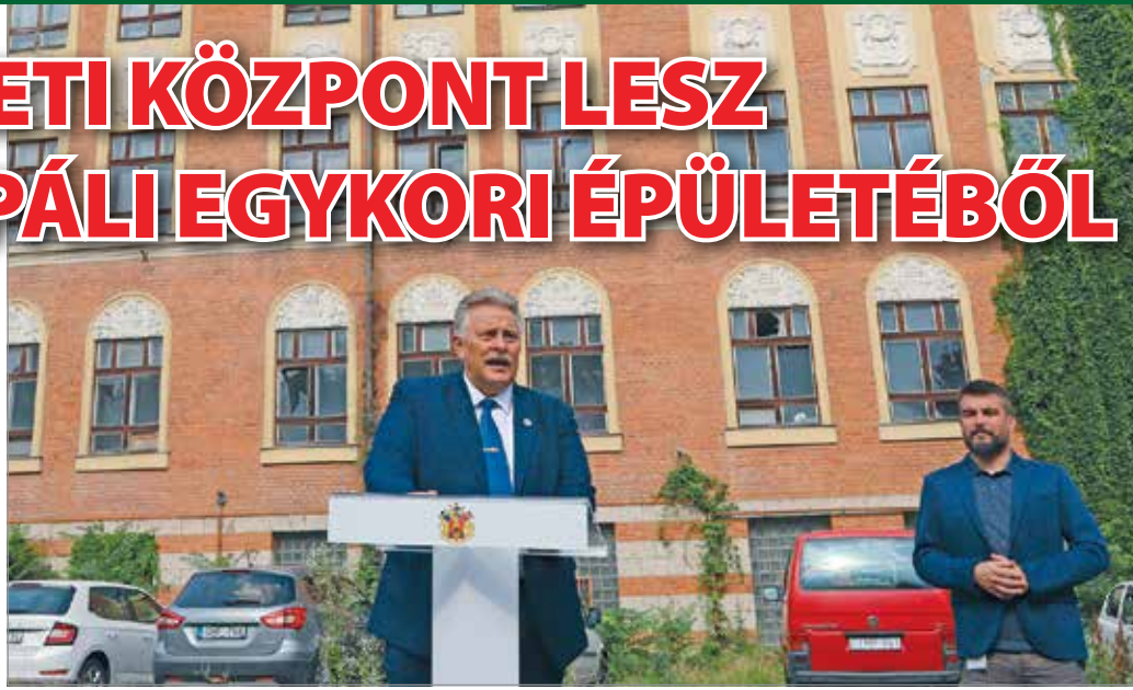
A csütörtöki sajtótájékoztatót követően átadták a munkaterületet az építkezést lebonyolító vállalkozónak. Fotó: Mocsári László
