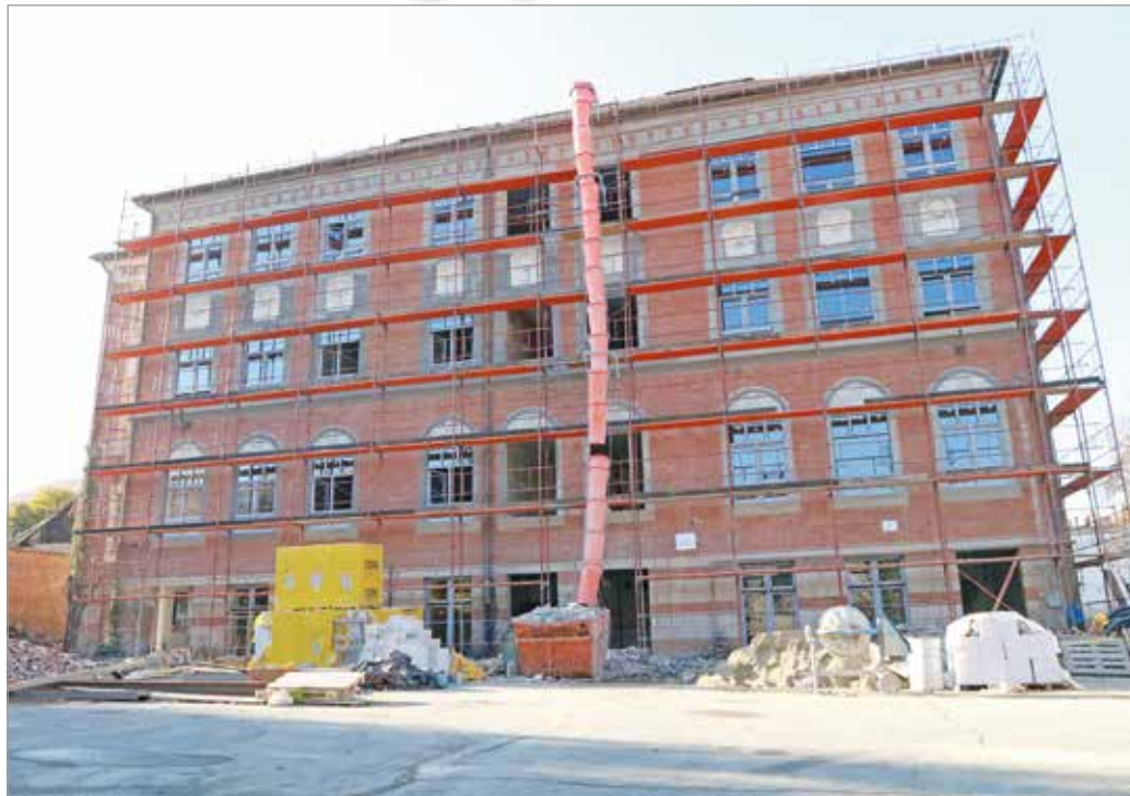
Jelenleg a nyílászárók beépítésén dolgoznak. Fotó: Parai Roland
