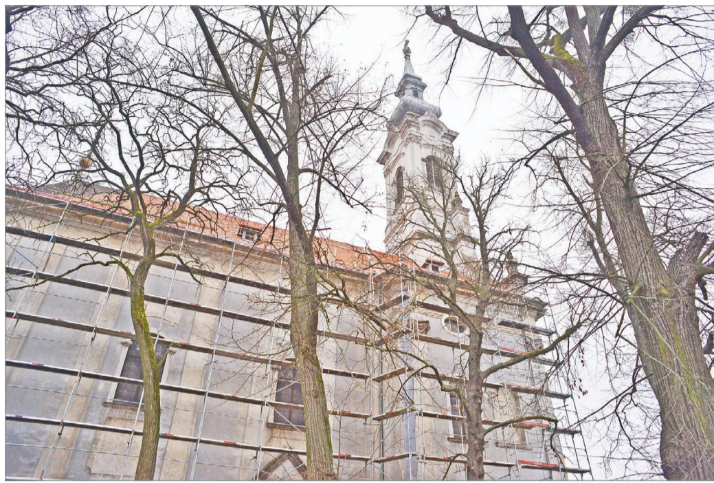
A nagy múltú épületet kívül-belül felújítják. Fotó: Osztie Tibor
